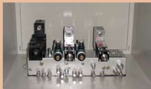
Гидрораспределители, установленные в отдельном шкафу около машины
